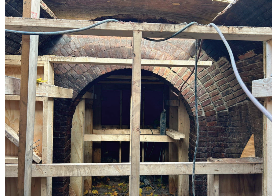
Het buisgat wordt hersteld
