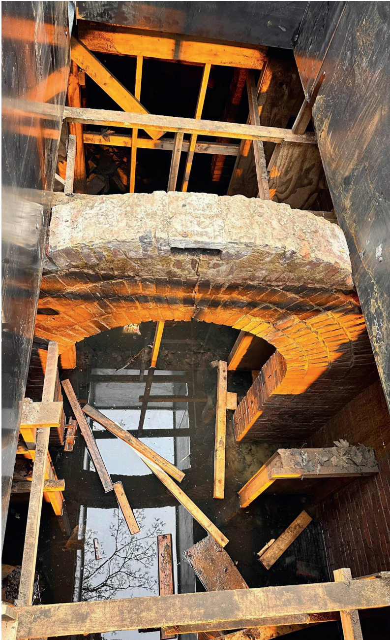
De waterbak met waterspiegeling na de restauratie
